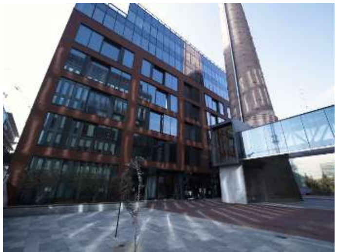
Unit.City «B11» - ул. Дорогожицкая, 3 GLA ≈ 6 000 м2
